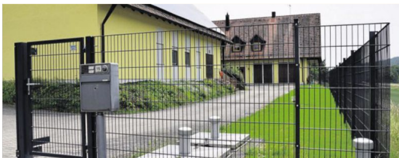
Für die Einzäunung, die Erneuerung der Eingangstüren und der Fenster im Wasserwerk Emhof sowie der Umzäunung des Brunnens Emhof hat der Zweckverband zur Wasserversorgung der Vils-Naab-Gruppe 105 000 Euro investiert.
